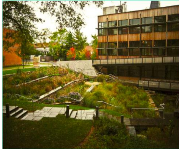
Traitement des eaux usées - USA
