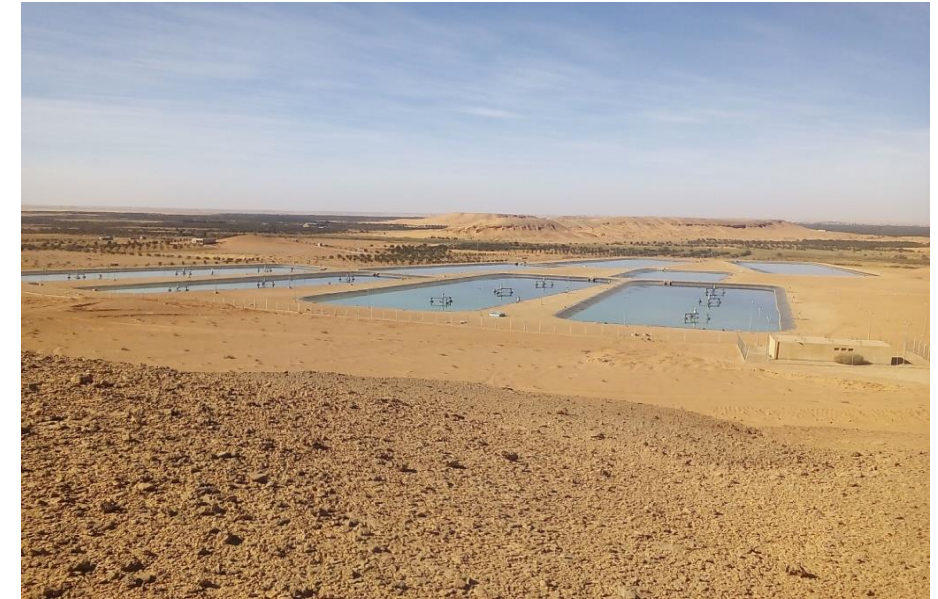
Les grandes STEP (l'assainissement conventionnel)
