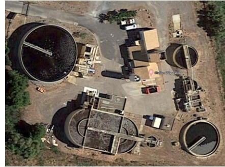
Station d'épuration de PLN
